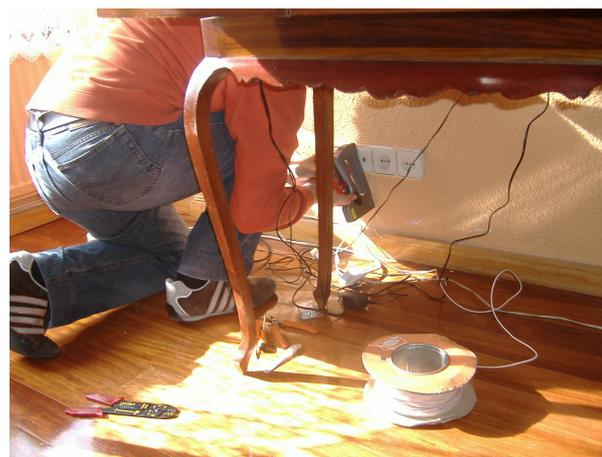
2: Fija el nuevo cable de teléfono (para el terminal) a la pared con una pistola de grapas
