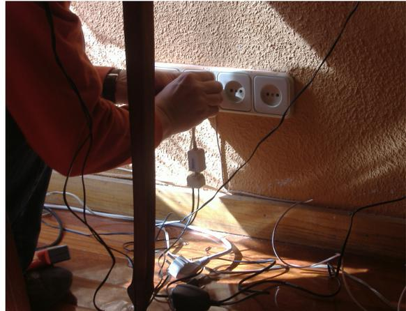
4: Vuelve a enchufar el cable del teléfono a la roseta para restablecer la conexión telefónica
